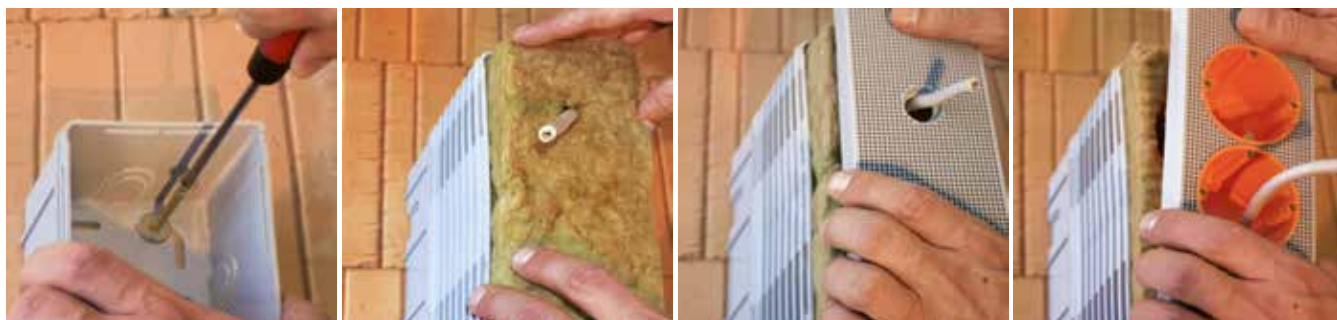
Bild 19: Türkommunikationsanlage an gedämmter Fassade auf Geräteträger montiert
