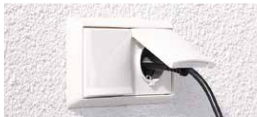
Bild 25: nachträglicher Einbau von Steckdosen in die gedämmte Außenfassade
