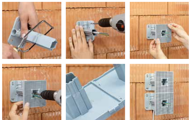
Bild 22: Montage eines Teleskop-Geräteträgers
