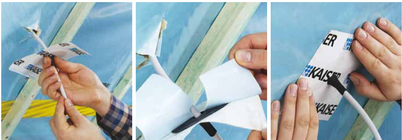
Bild 13: Luftdichte Durchführung einer Antennenleitung
