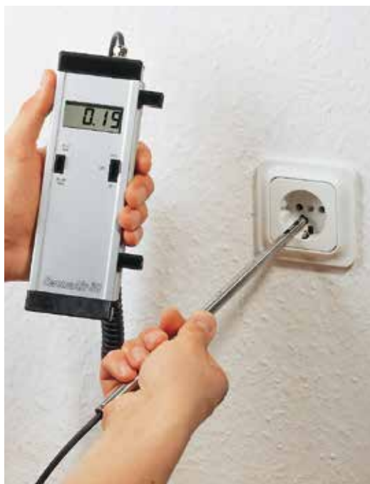
Bild 29: Leckageortung und Messung der Luftundichtheit mit dem Thermoanemometer
