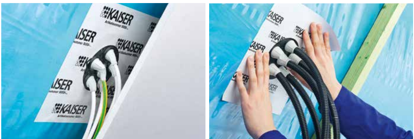
Bild 14: Abdichtung von Mehrfachleitungs- und Mehrfachrohrdurchführungen
