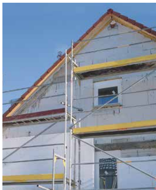
Bild 17: Dämmung der Außenfassade
